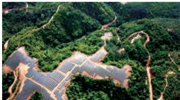
49 MWdc LSS2 project in Sik, Kedah
