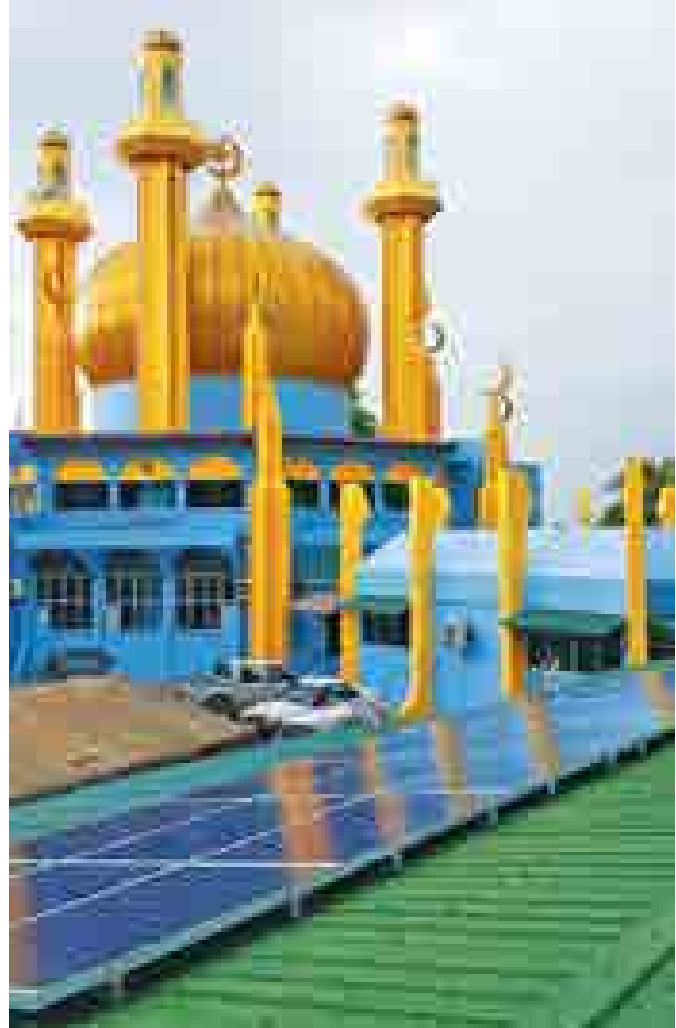
5kw system solar at Masjid Pekan Kota Belud
