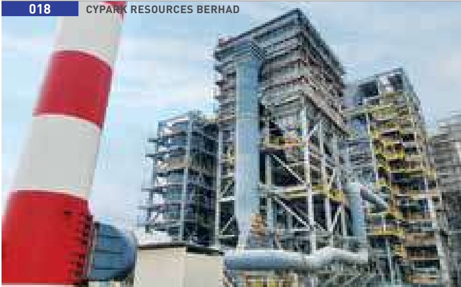
SMART WTE plant in Ladang Tanah Merah, Negeri Sembilan
