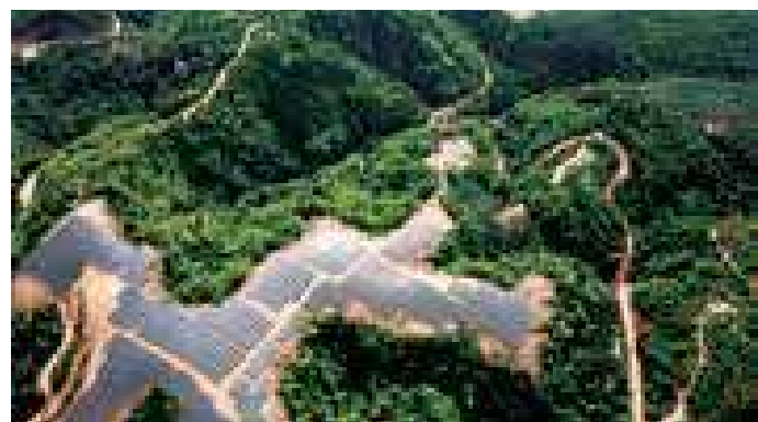
49 MWdc LSS2 project in Sik, Kedah
