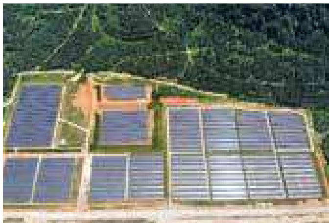
11 MWdc solar plant in Ladang Tanah Merah, Port Dickson, Negeri Sembilan.
